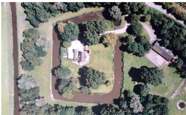
Luchtfoto van het huidige Huys te Gapinge, waarop de oude slotgracht mooi in beeld is gebracht (met dank aan luchtfotograaf Peter Buteijn).
